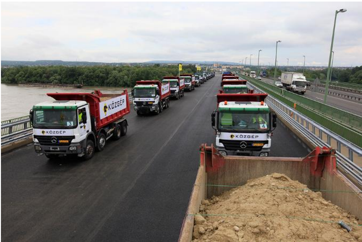
3-4 A statikus terhelek(járművek) elhelyezkedése a Hárosi Duna-hídon [BMEH]
