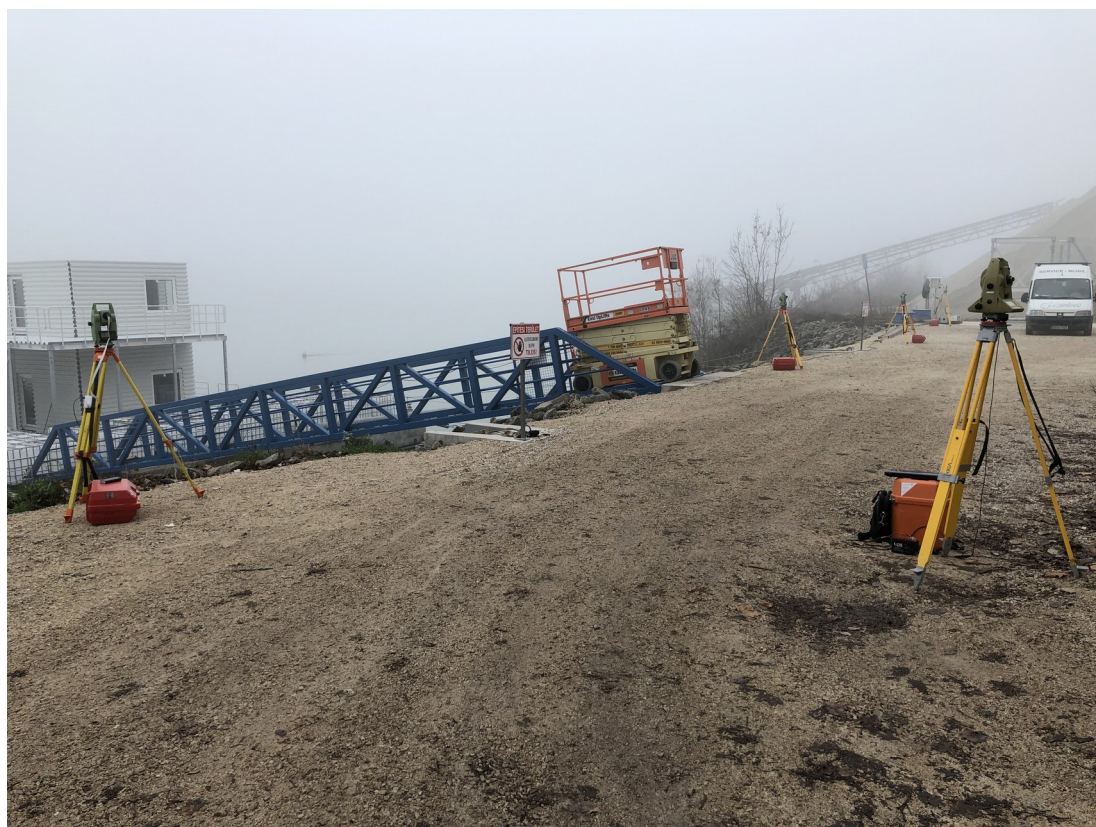
58. Ábra: Felállított rendszer
