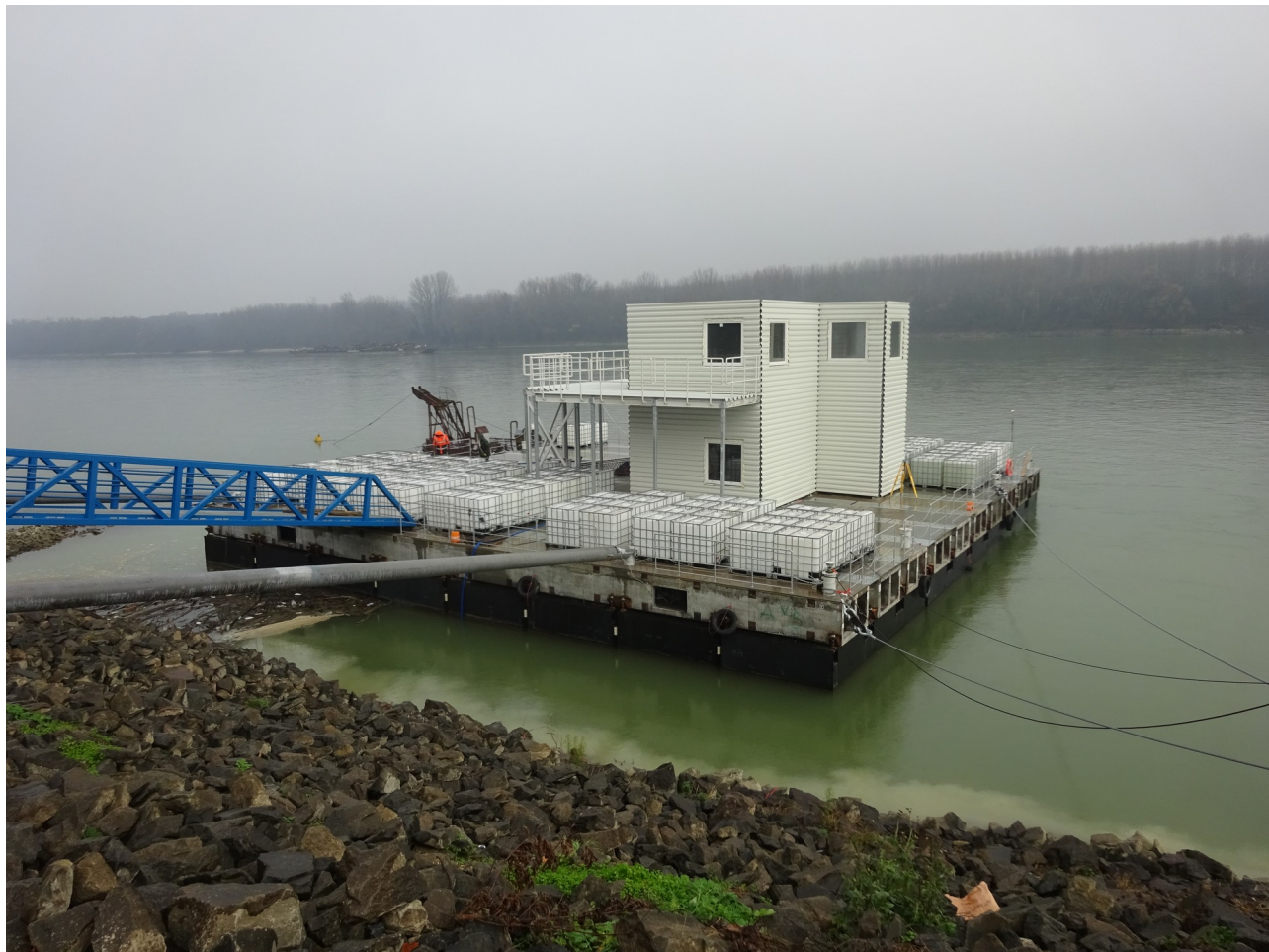
53. Ábra: Felépítmény és IBC tartályok Forrás: Takács Bence
