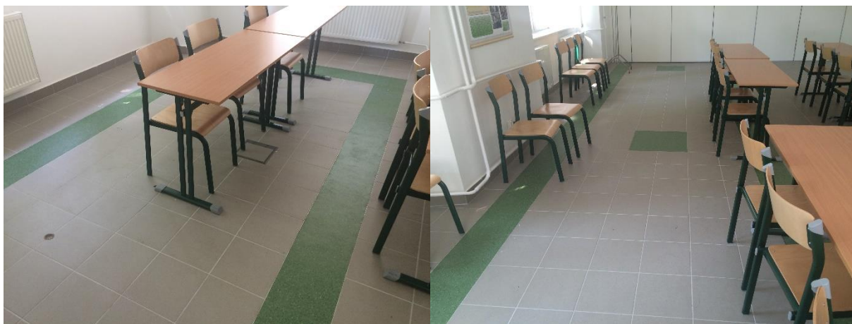
37. ábra Bal oldalt látható a zöld csík, mely az elkülönült alapozást jelöli, jobbra pedig a két fedél, amely a pontokat rejt
